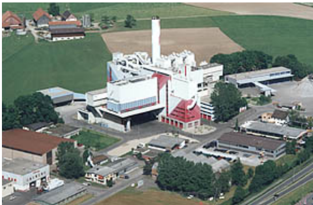
Abbildung 1: Kehrichtverbrennungsanlage Hinwil (ZH)
